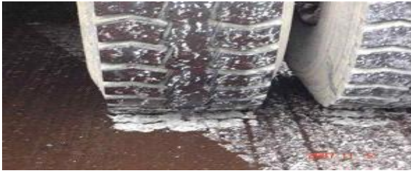
<그림 5> 덤프트럭에 의한 택코팅 손실
